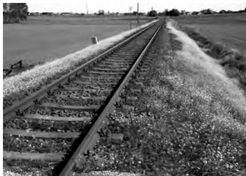
Tor wiosną w Brusach - wybudowanie.
