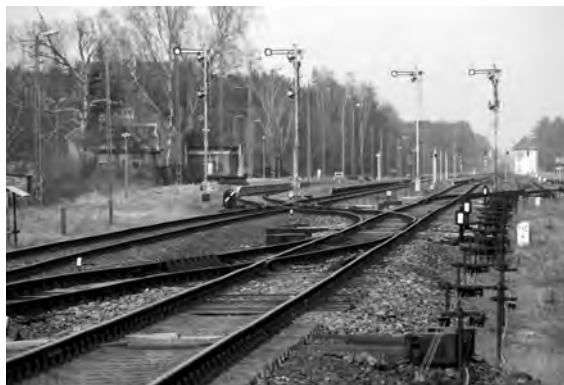
Stacja kolejowa w Bąku.
