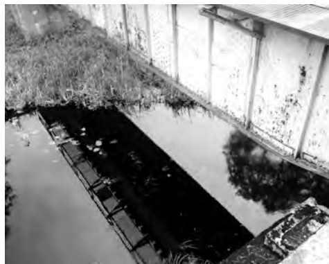
Most kolejowy w Zawadzie.
