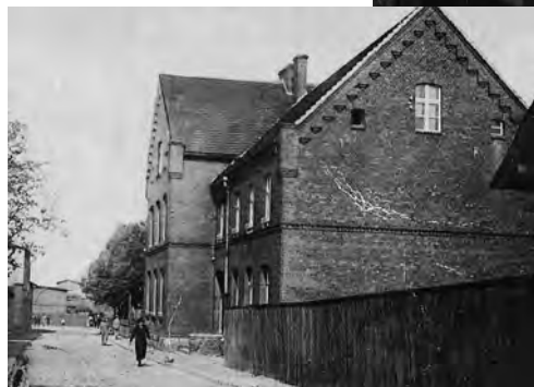
Budynek SP, w skrzydle wschodnim filia ZSZD od 1959 r.
